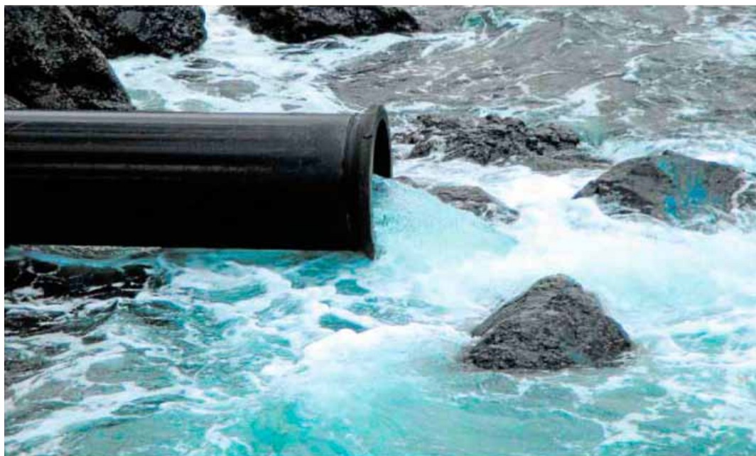
Uno de los problemas de la gestión del agua en Canarias es la obsolescencia de las infraestructuras. c7
