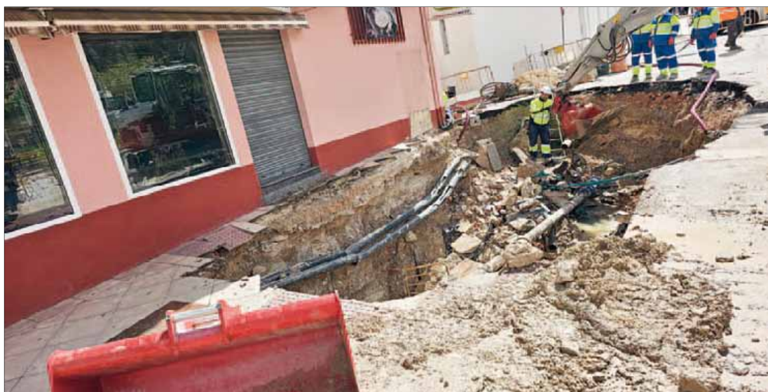
REPARACIÓN. Técnicos municipales trabajan en el arreglo del colector de aguas que provocó el socavón en la Avenida de Arjona.
